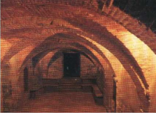
Figura 5: cripta alla porta santa della chiesa di SS Salvatore
